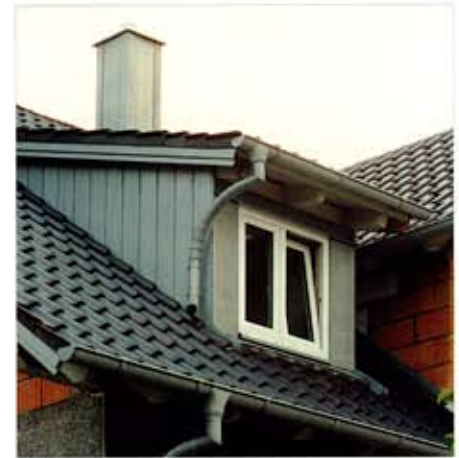
Schmale Paneele mit Einhängfalz, schön und wellenfrei
